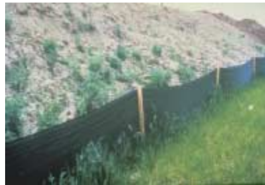
(d) Silt fence
